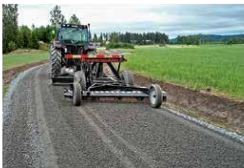
Pirms CC road® izkaisīšanas ceļš tiek līdzināts. Ietecamais šķērskritums grants ceļam ir 3 – 5%, kas nodrošina labu
